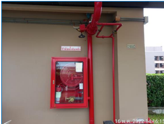
รูปที่ 2.32 ตู้เก็บสายฉีดน้ำดับเพลิงและถังดับเพลิง
