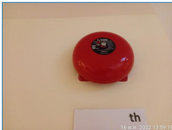
รูปที่ 2.30 สัญญาณแจ้งเหตุเพลิงไหม้
