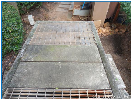
รูปที่ 2.10 ตะแกรงดักมูลฝอยที่บ่อพักน้ำสุดท้ายก่อนระบายออกนอกโครงการ
