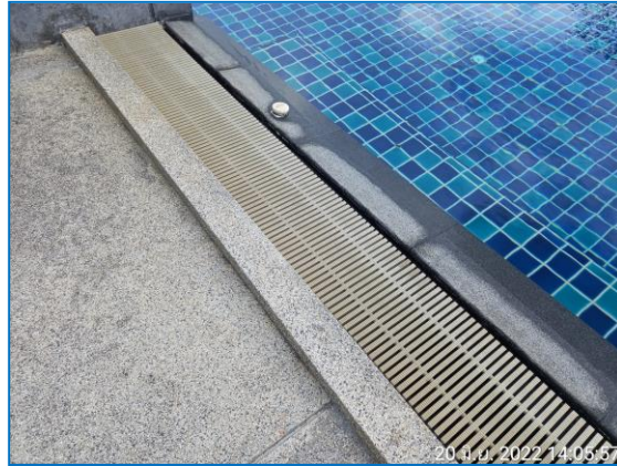
รูปที่ 2.47 รางระบายน้ำล้น และฝาปิดของสระว่ายน้ำ
