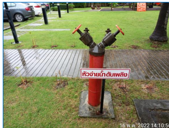
รูปที่ 2.34 หัวรับน้ำดับเพลิง และหัวจ่ายน้ำดับเพลิง
