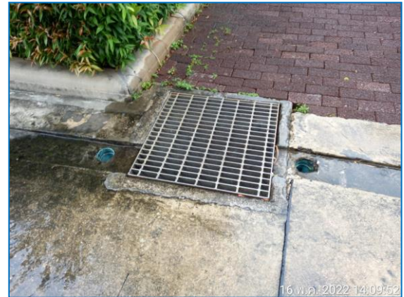
รูปที่ 2.23 ท่อระบายน้ำและบ่อพักน้ำสามารถทวนน้ำได้
