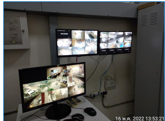
รูปที่ 2.39 ระบบโทรทัศน์วงจรปิด (CCTV) และห้องควบคุม (Control)
