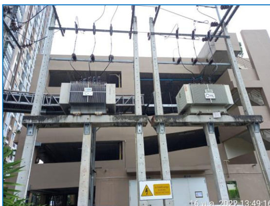
รูปที่ 2.38 หม้อแปลงไฟฟ้า
