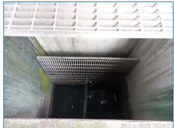
รูปที่ 2.10 ตะแกรงดักมูลฝอยที่บ่อพักน้ำสุดท้ายก่อนระบายออกนอกโครงการ
