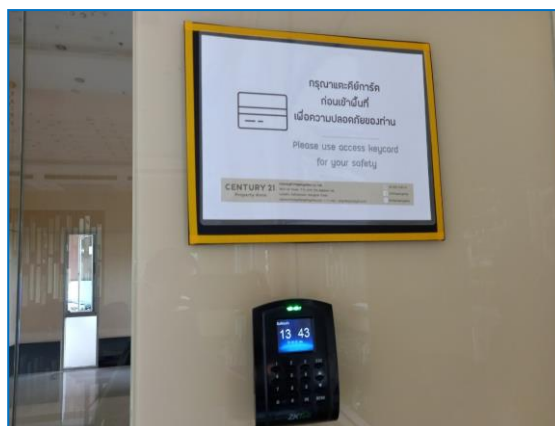
รูปที่ 2.17 ระบบความปลอดภัยแบบ Key Card
