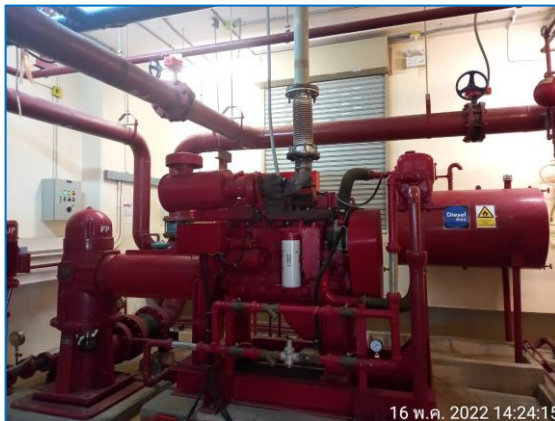
รูปที่ 2.36 ระบบ Fire Pump และถังเก็บน้ำสำรองดับเพลิง
