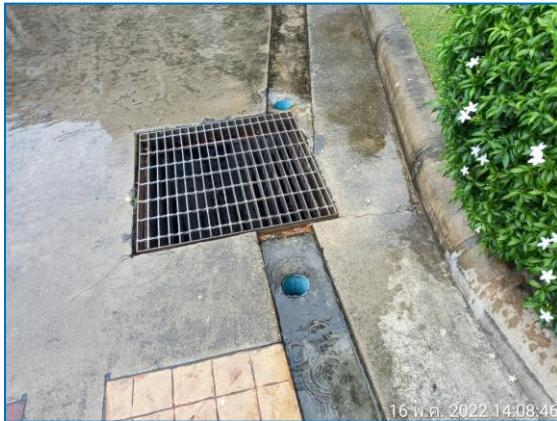
รูปที่ 2.23 ท่อระบายน้ำและบ่อพักน้ำสามารถทวนน้ำได้
